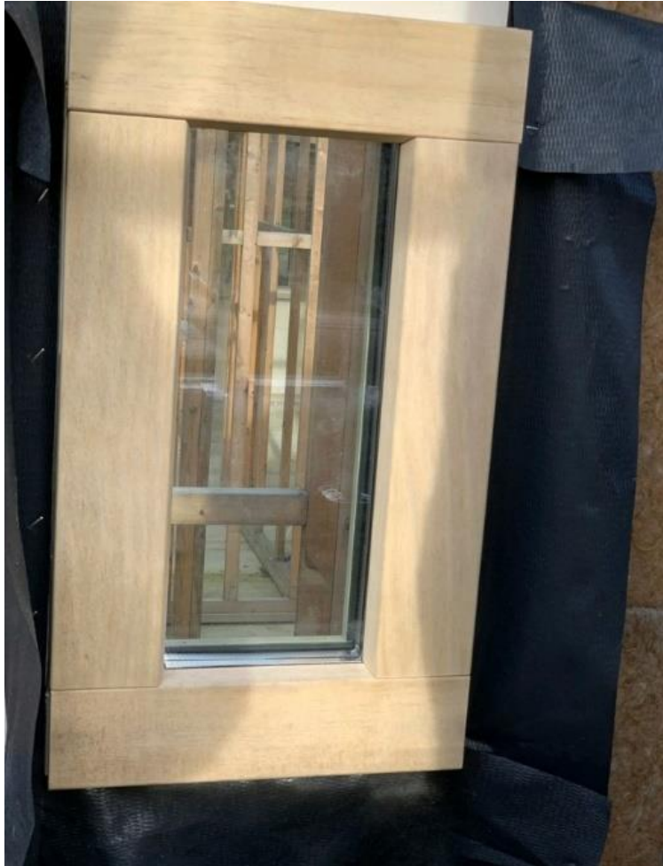
Figuur 6 – Totaalbeeld kozijn
