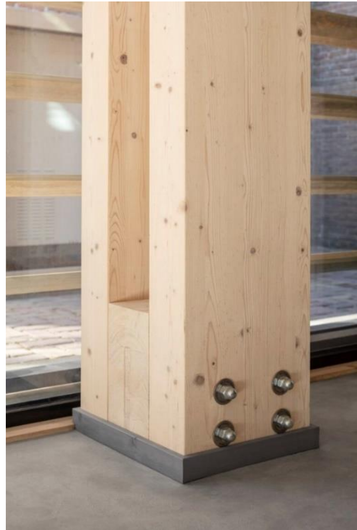
Figuur 21 – Gelamineerde houten kolom (I)
