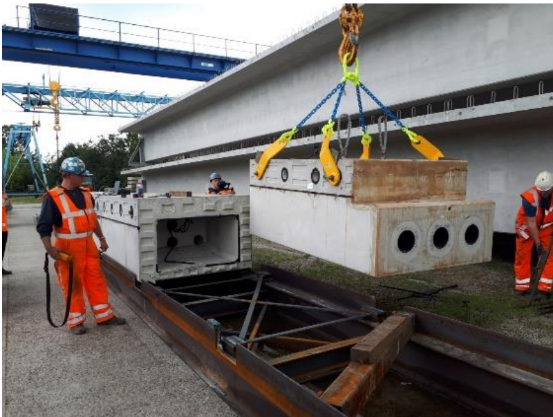
Figuur 38 – Viaduct Kampen (4)
